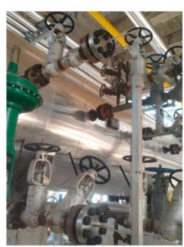
◆ 差压表,单,双法兰液位,DP 表投运时需要注意的问题。带静压,排污,排气,需要考虑法兰应力和温度变化等。正负迁移的问题。
